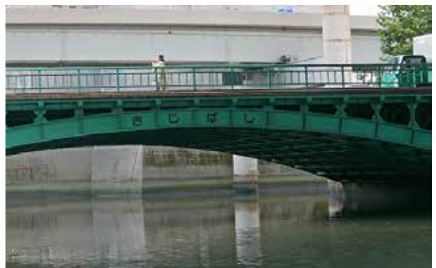
きじばし 雉橋（日本橋川の鉄骨造り上路アーチ橋、大正14年）
