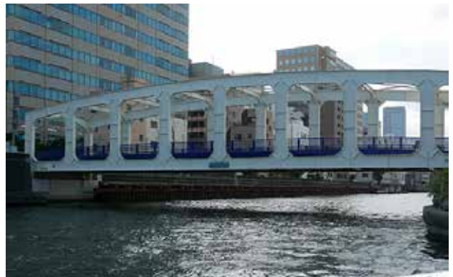
とよみぼし 豊海橋（日本橋川、隅田川への合流点。昭和2年） フィーレンディール橋という形式の橋だそうです。
