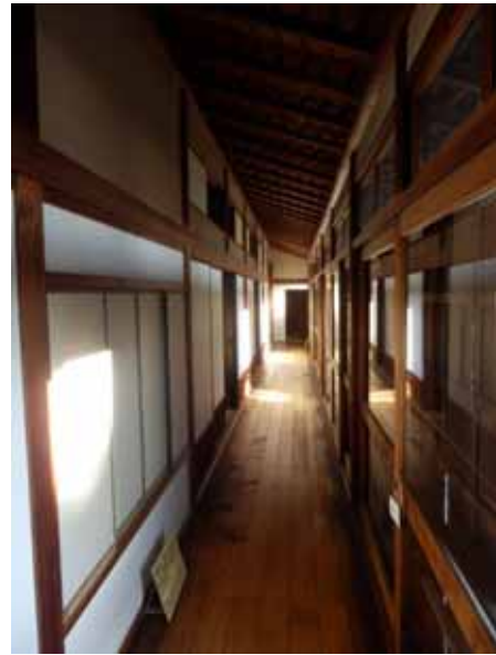
2階縁甲板張りの廊下：樽縁 くればん
