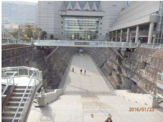
旧横浜船渠（三菱重工横浜造船所）第2号ドック跡： 現存する日本最古の石造りドックヤード 重要文化財，全長 107m・全幅 29m・深さ 10m
