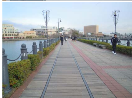
下の写真のこの橋梁はイギリス製。
